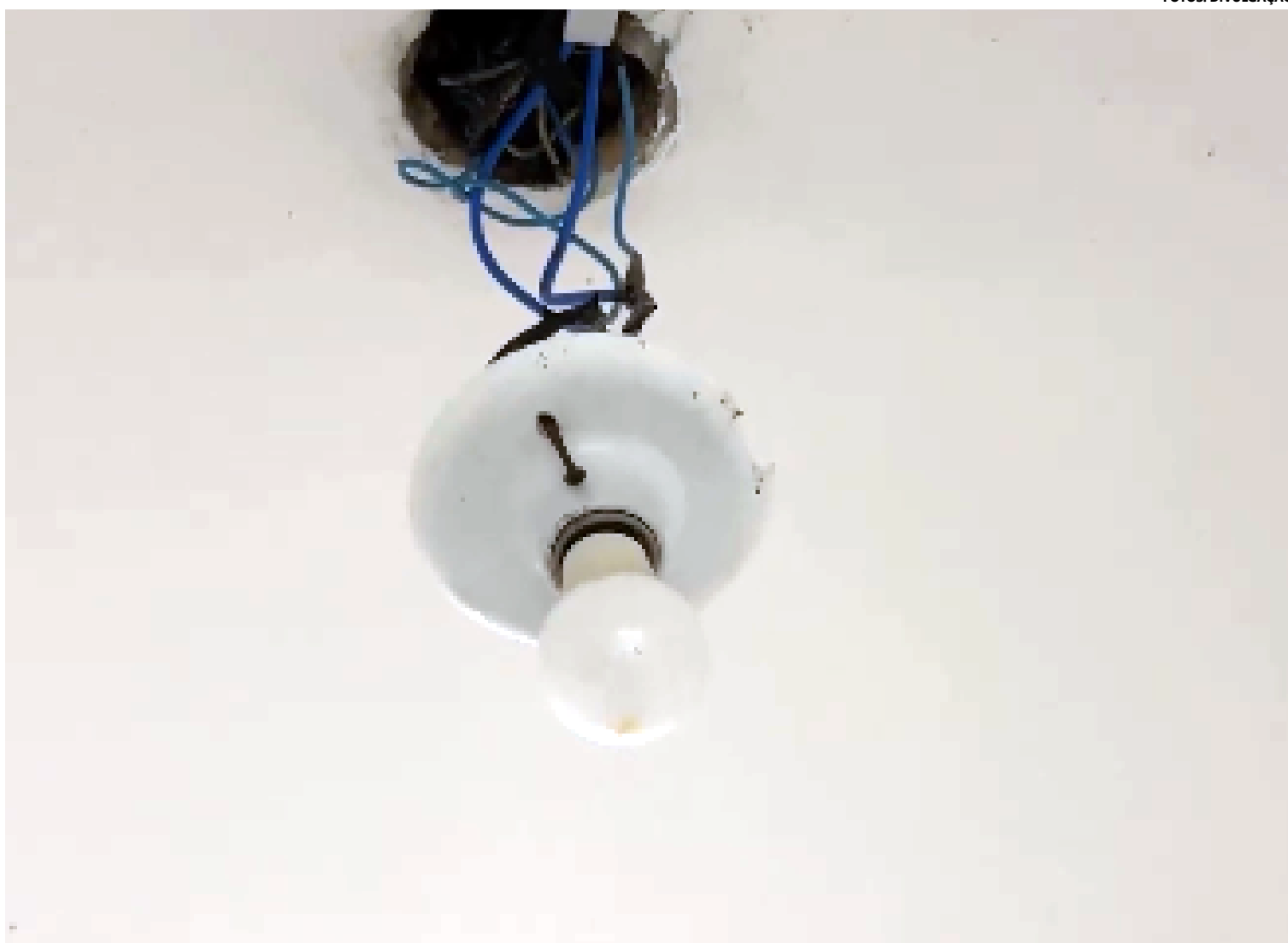
várias instalações de iluminação dentro do hospital estão em condições precárias, o que representa riscos tanto para os pacientes quanto para os funcionários da instituição
